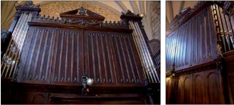
Figs. 7 y 8. Detalles de la fachada principal.
